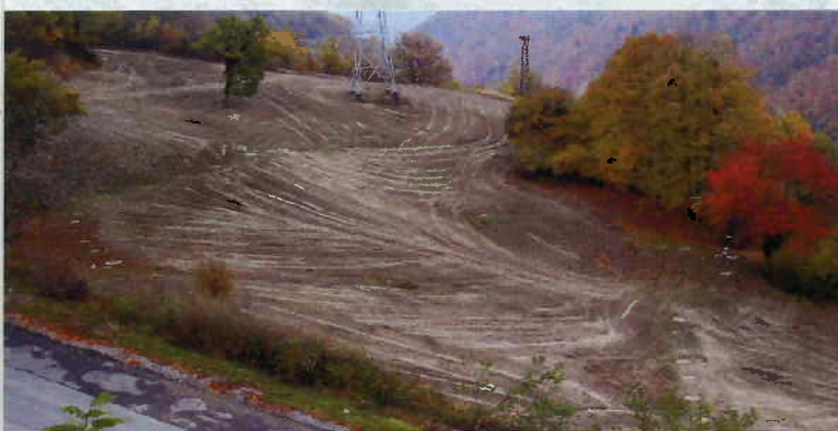
La motte Saint Martin (38) : 50 piézomètres et 2 débitmètres
